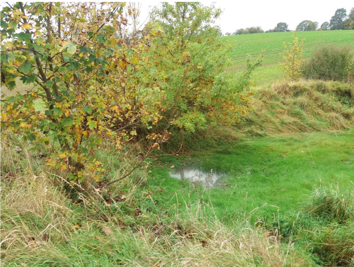
Abbildung 13: Bestand Fotopunkt 8: Regenrückhaltung, Quelle Auktor Ing. GmbH, 10.10.2017
